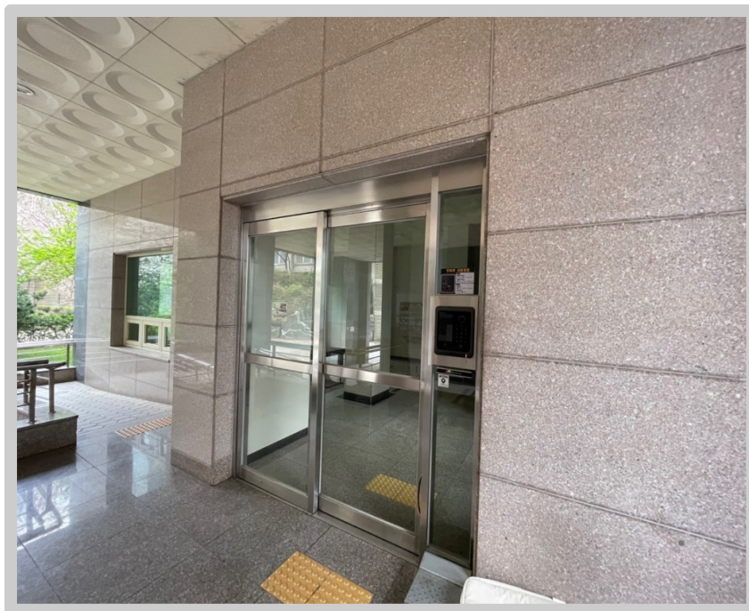
【 대상건물 1층 출입구 전경 】
