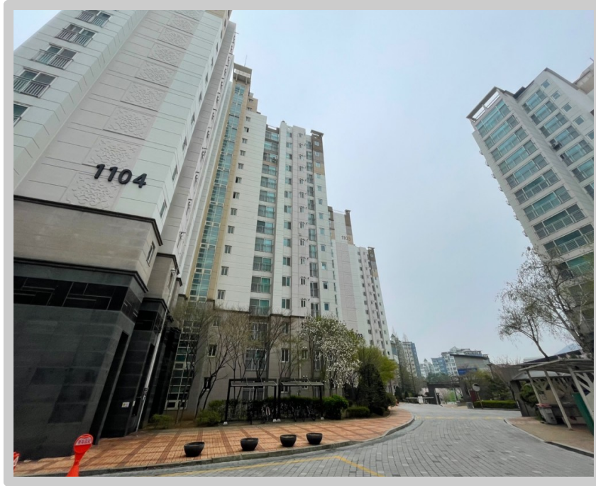
【 대상건물 주위(북동측) 전경 】
