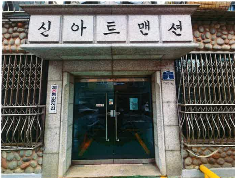
본건 출입문 전경
