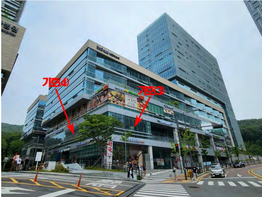
본건 건물 전경 남서측 (기호3~5)
