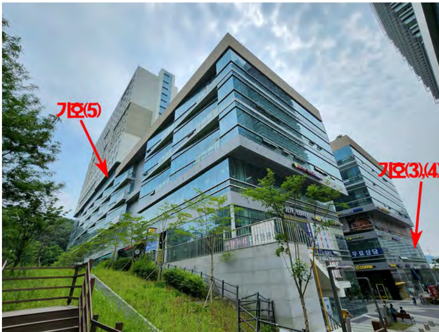
본건 건물 전경 북서측 (기호3~5)
