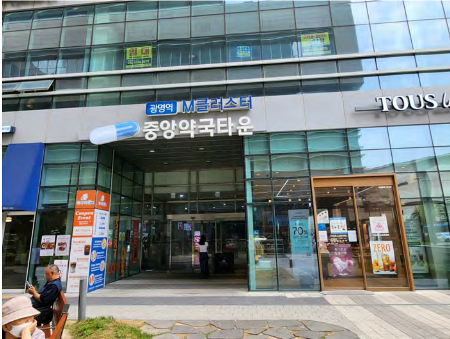
건물 지하1층 출입문 (기호3~5)
