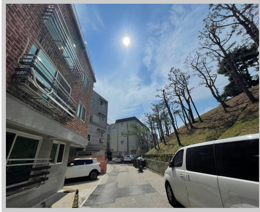
【 대상건물 남서측 전경 】
