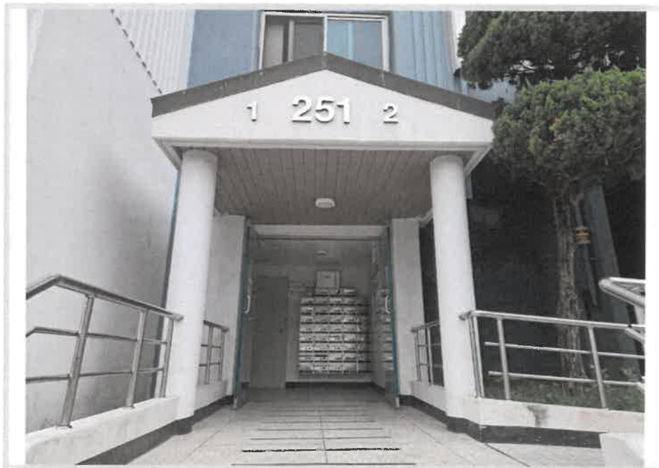
주 출입구 전경
