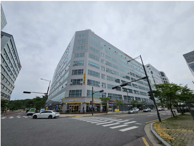
본건 건물 전경
