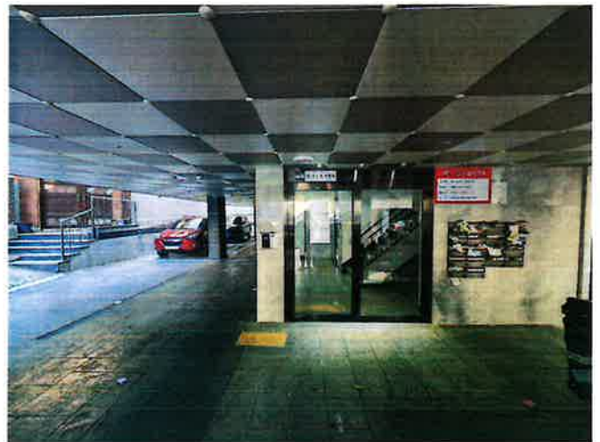
본건 공동현관 출입구 전경
