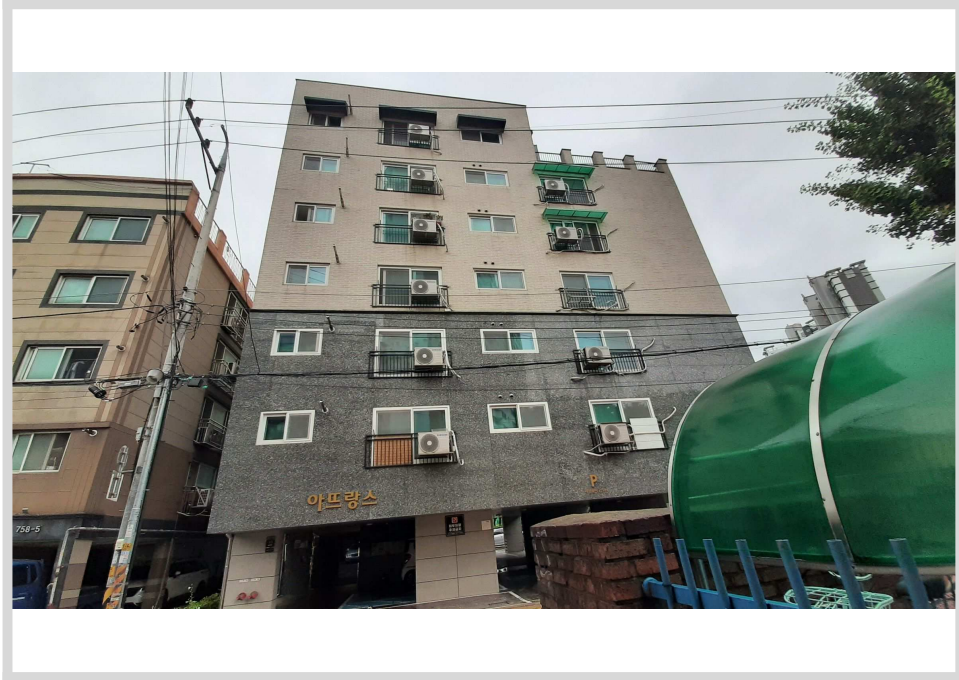
<본건 건물, 남측 촬영>>
