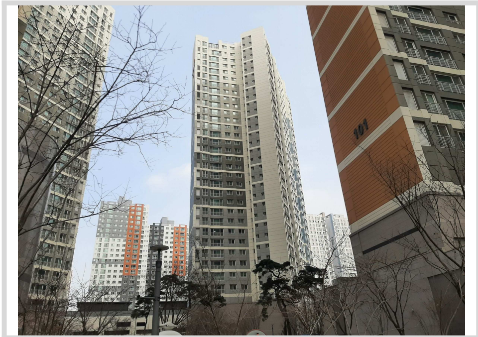
시흥배곧씨1호반써밋플레이스 제106동 전경
