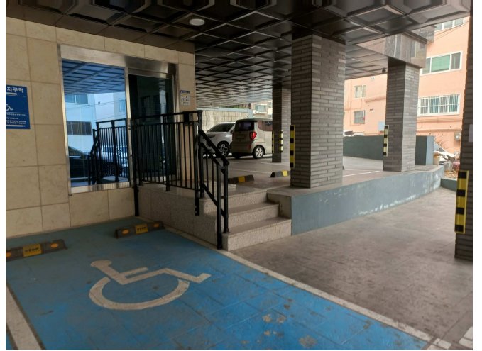
본건 1층 피로티 주차장
