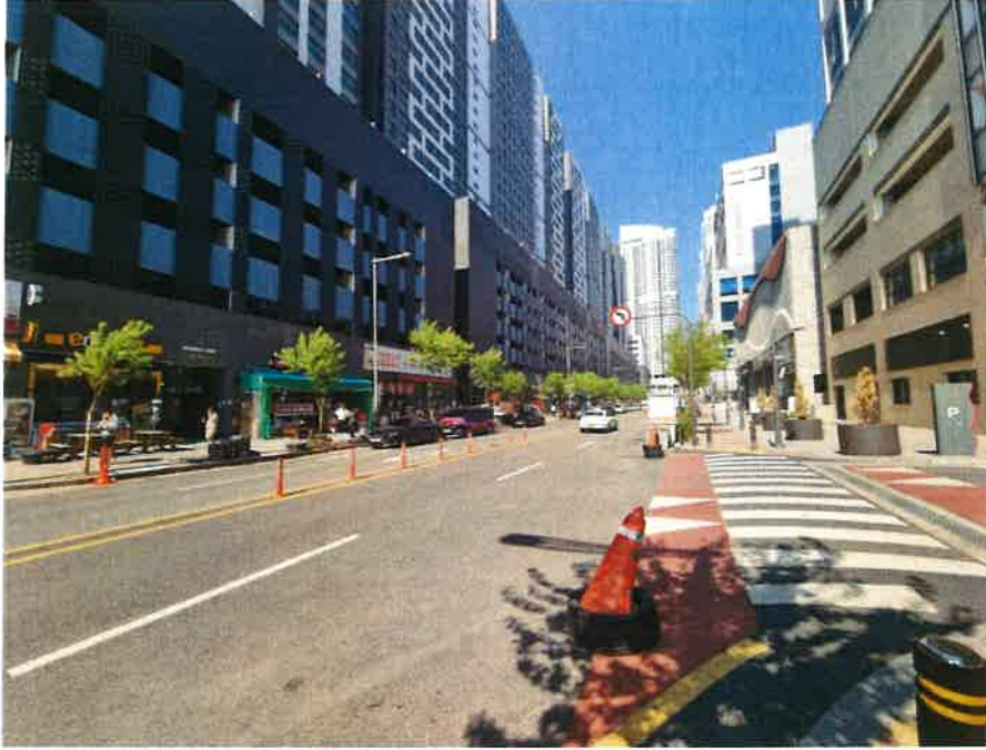
본건 접면도로 전경
