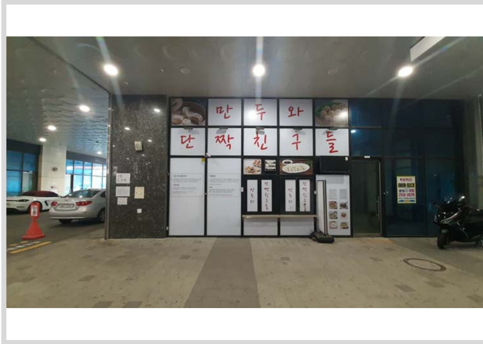
<본건 전경, 남측 촬영>
