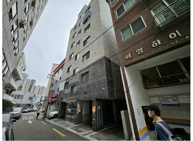
본 건물 북측 전경 및 주위 환경
