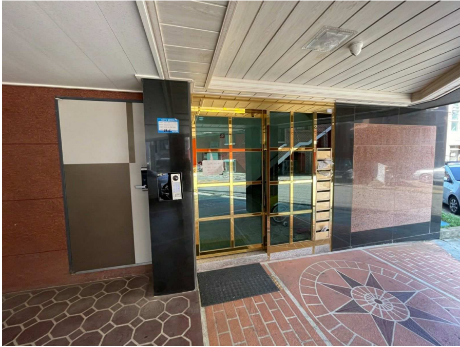
1층 공동 현관문
