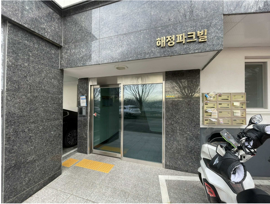
1층 공동 현관문
