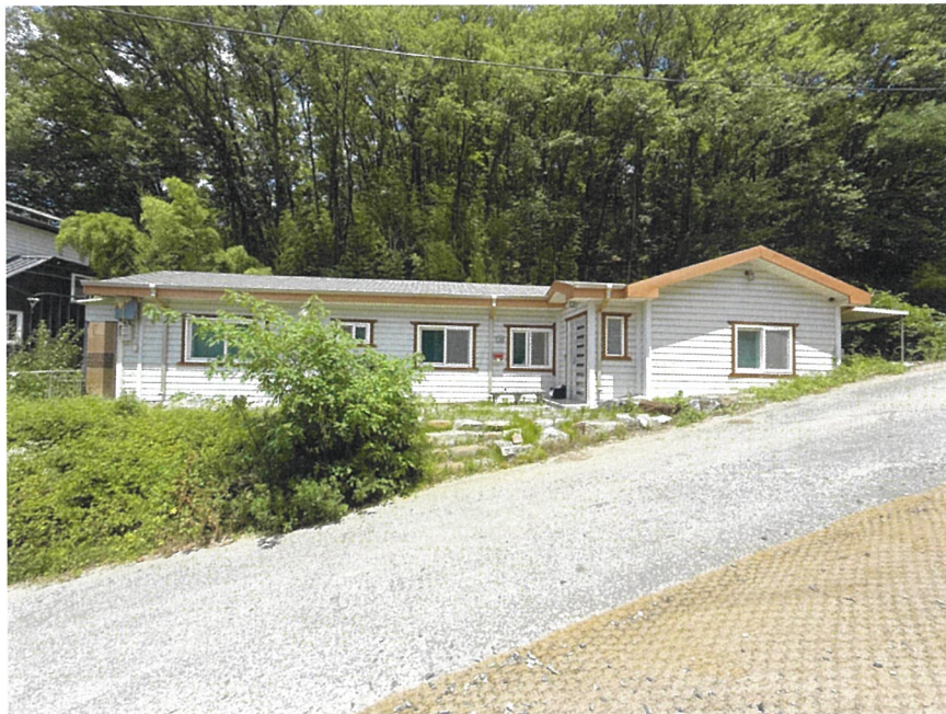
일련번호(가) 건물 전경
