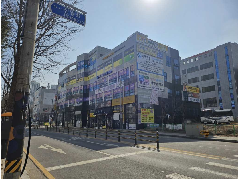
본건 건물 전경
