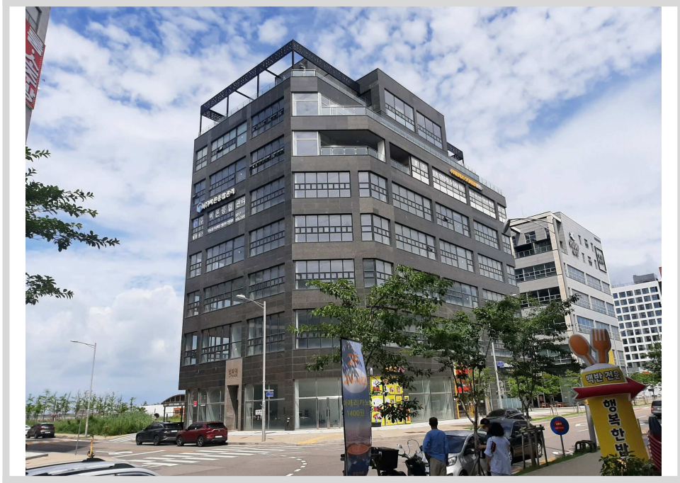
엘타워 남동측 전경
