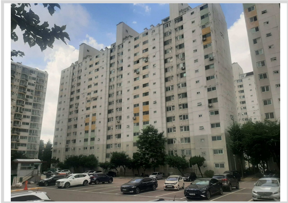
공작한양아파트 제125동 북서측 전경
