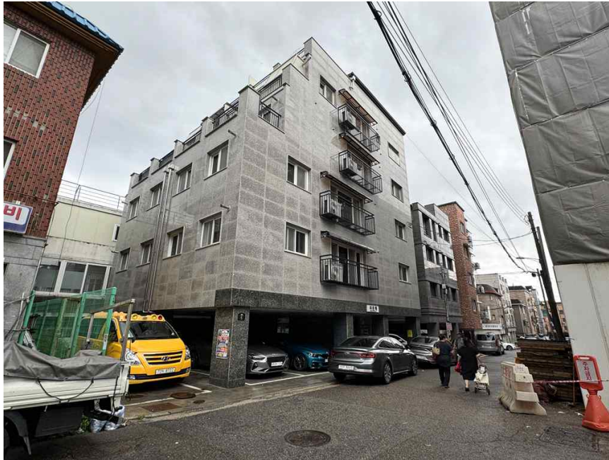
대상물건이 속한 건물의 전경
