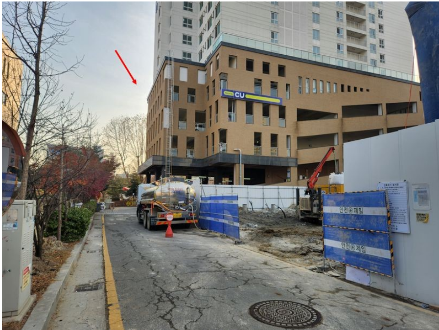
<본 건 진입도로 - 북측 촬영>
