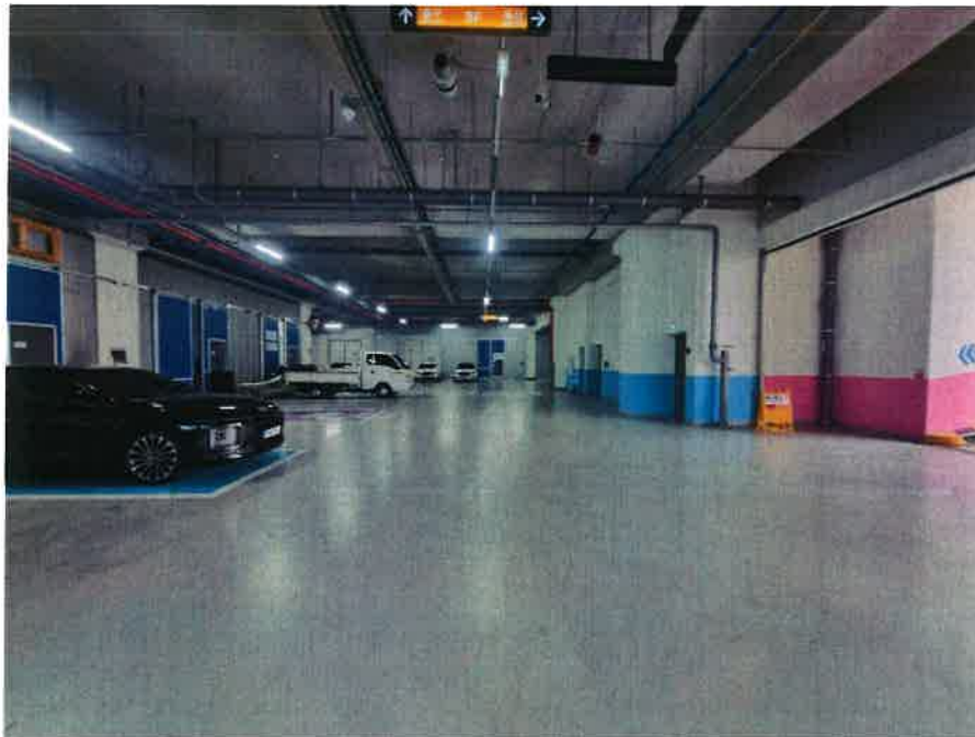
본건 건물 내부 전경
