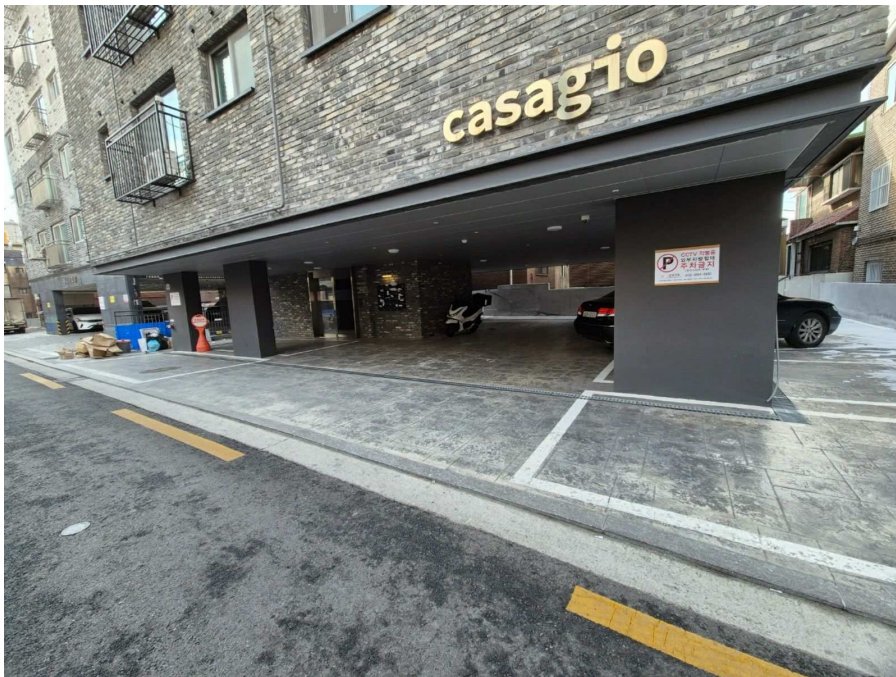
1층 주차장 전경
