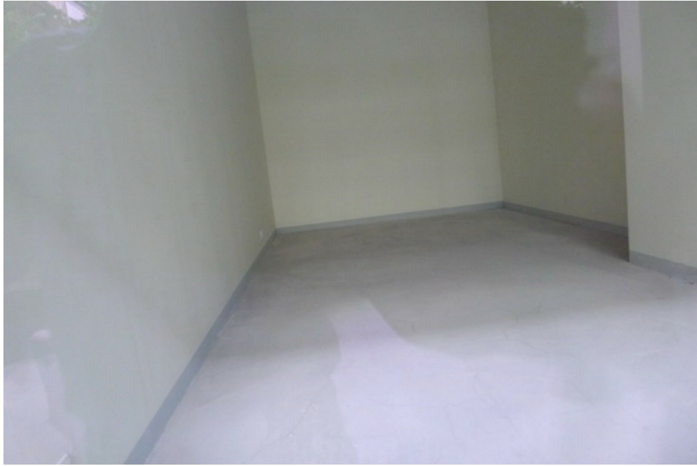
115호 내부(출입문 외부에서 촬영)
