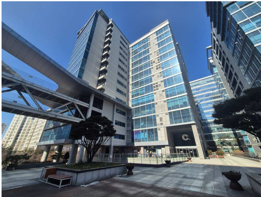
본건 건물 전경
