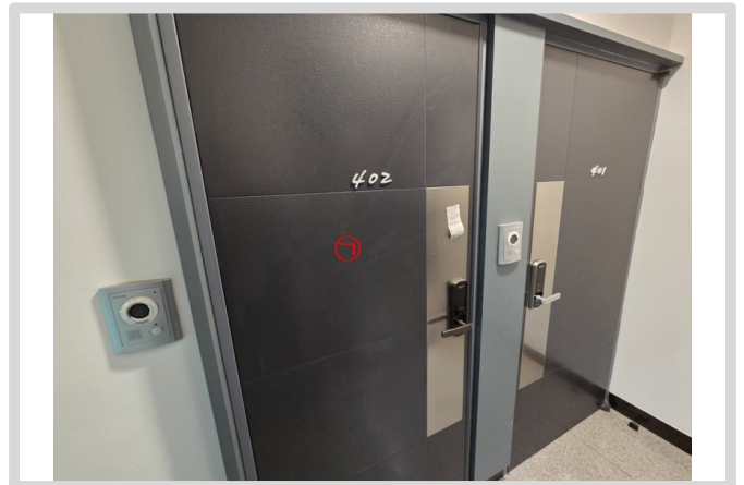
【기호(1) 4층 통로 및 제시외건물㉠ 입구】
