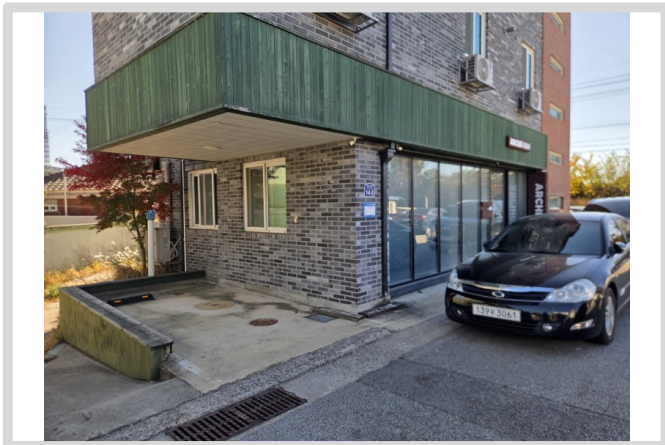
【기호(1) 1층 근린생활시설】
