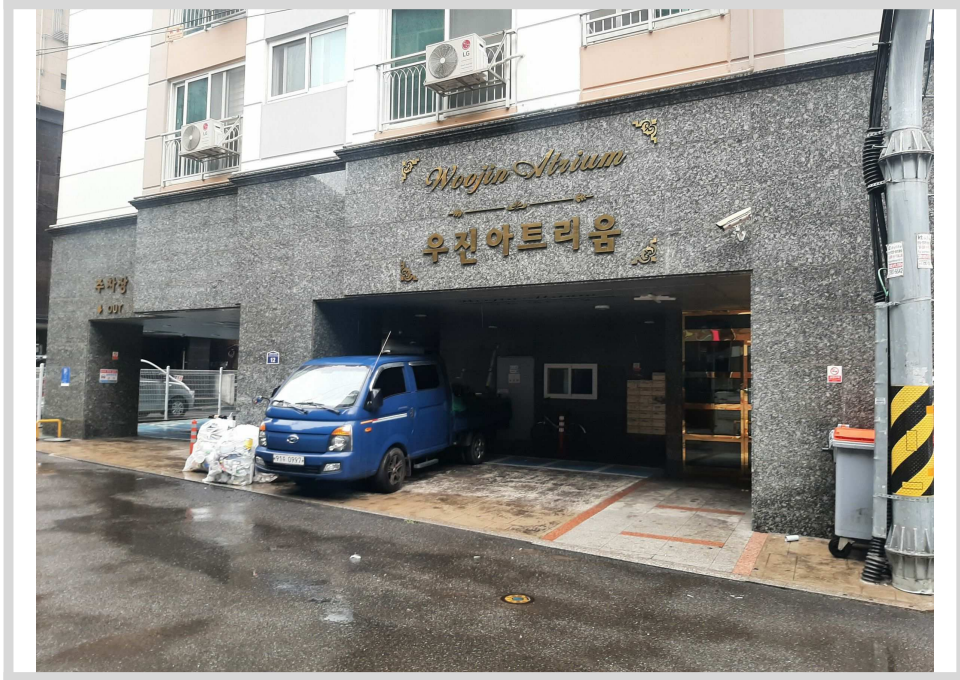
우진아트리움 주차장 및 1층 출입구
