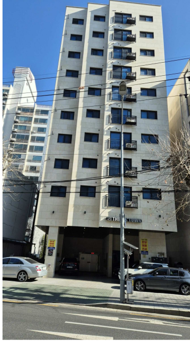
본건 소재 건물 전경 (남서측에서 촬영)
