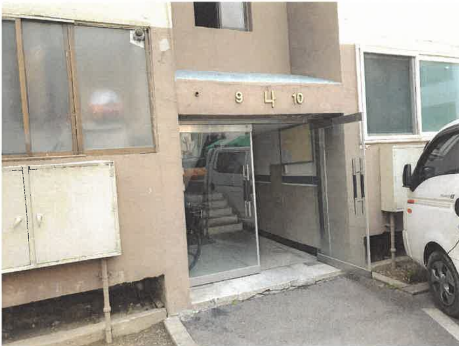
본건 1층 출입문
