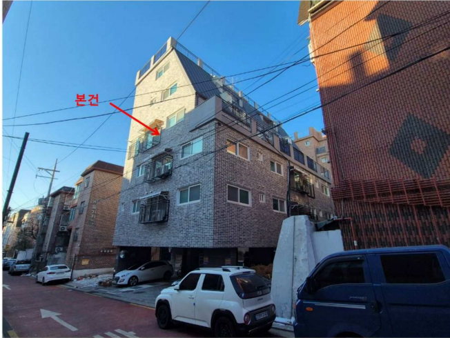
북동측에서 촬영한 본건 건물 전경
