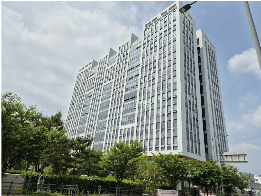
대상건물 전경 - 북동측에서 촬영
