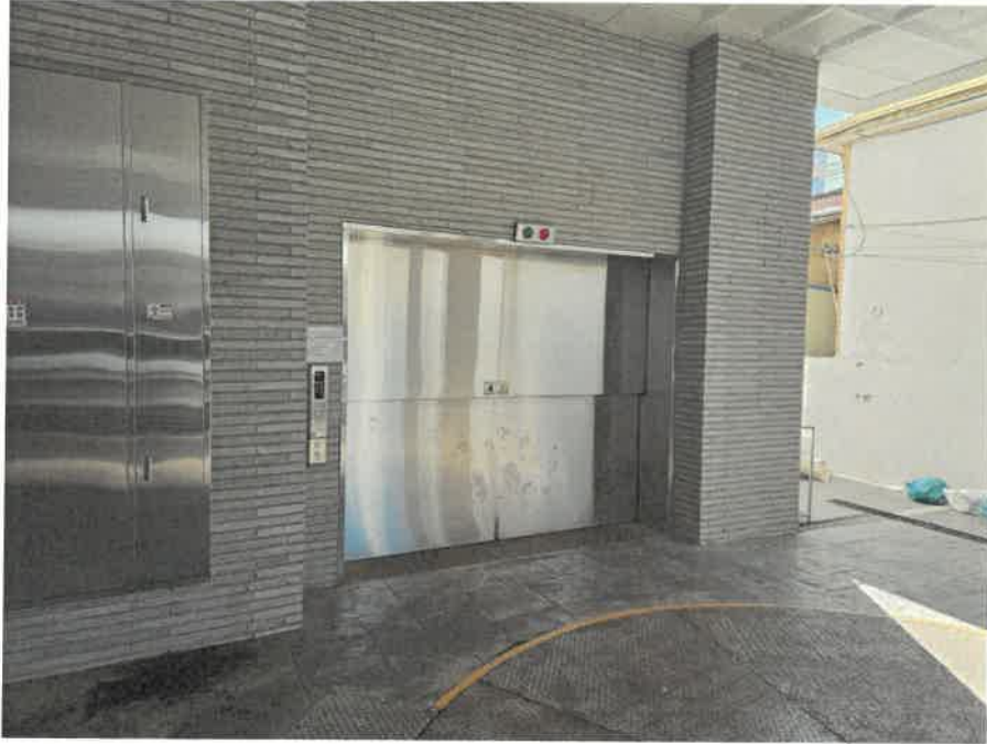
기계식 주차장 설비
