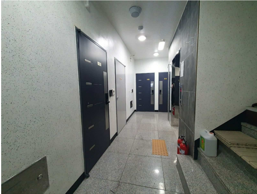
본건 앞 복도 전경
