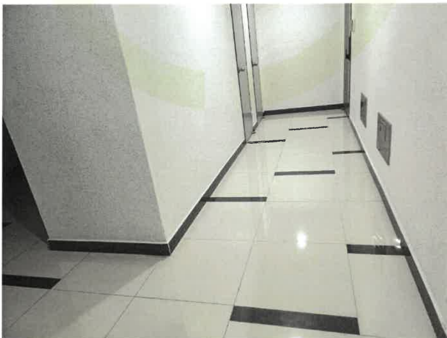
12층 복도 전경
