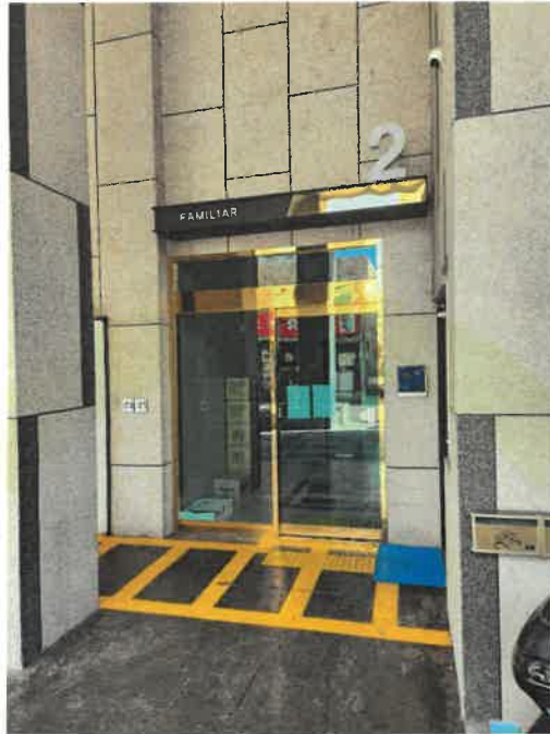
본건1층 공동 출입문 전경
