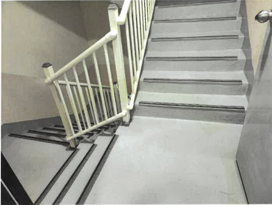
각층 공동비상계단 전경
