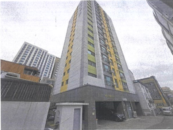
본건 전경(남서측에서 촬영)
