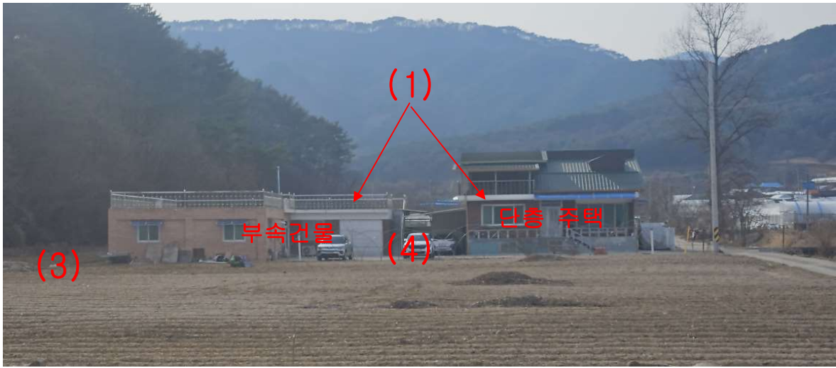
본건 기호(1) 건물 및 기호(3),(4) 토지 일부 전경 (동측에서 촬영)
