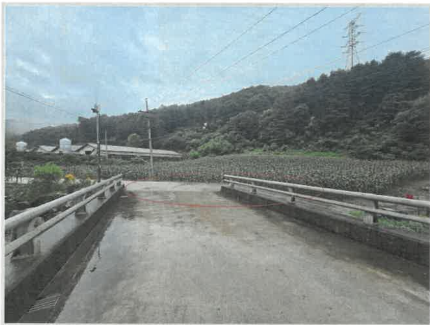
【 본건 전경(기호2 도로 부분) 】
