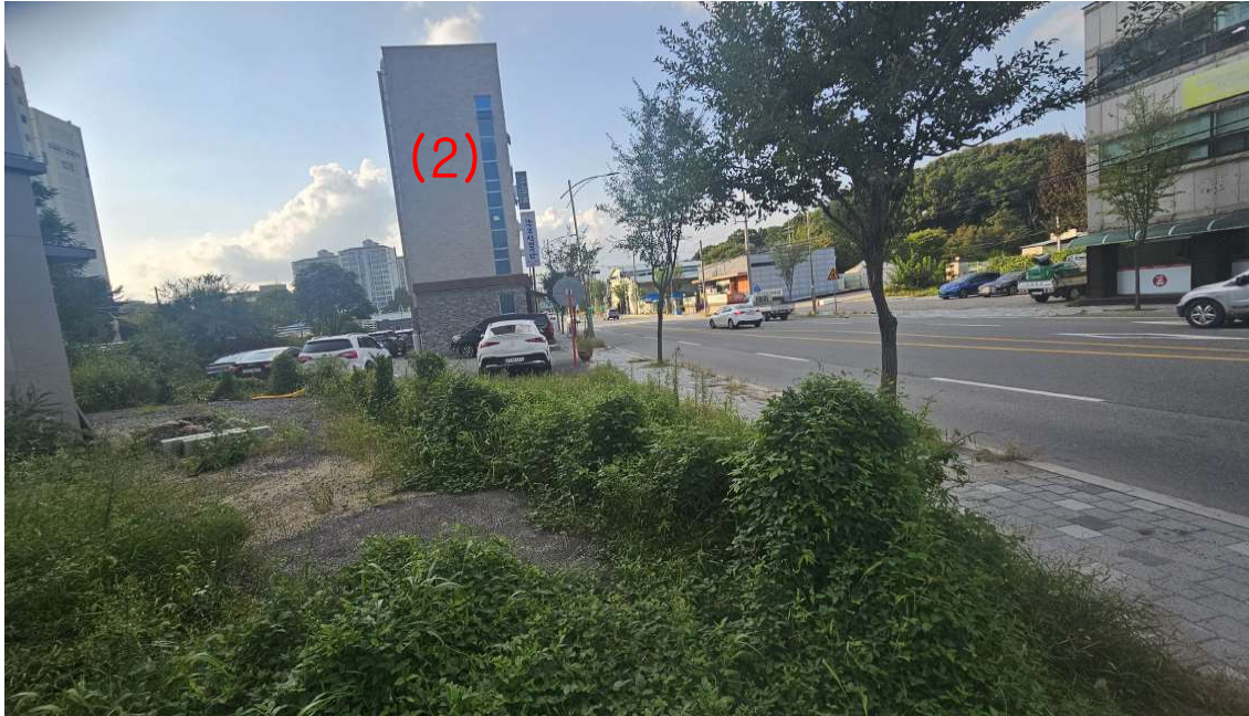
본건 기호(1) 토지 및 기호(2) 건물 전경
