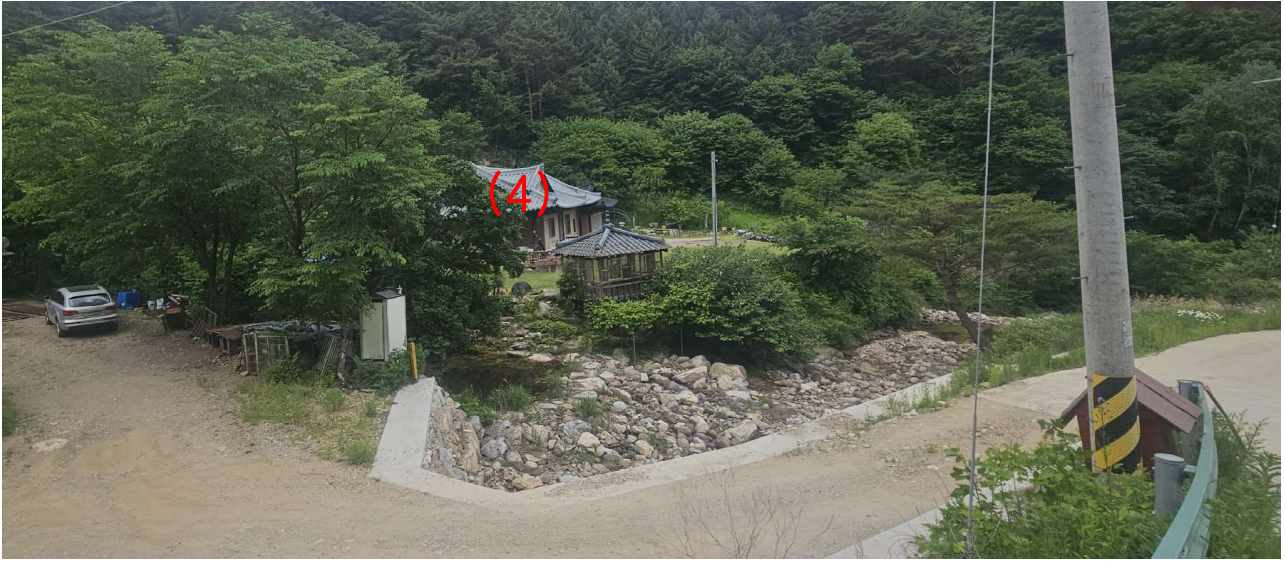
본건 기호(3),(5) 토지 및 기호(4) 건물 전경
