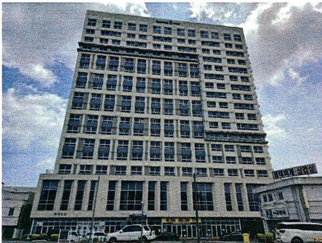
본건 건물 북서측 전경
