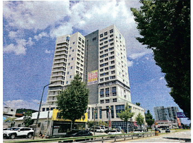
본건 건물 남서측 전경
