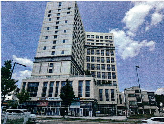
본건 건물 남동측 전경
