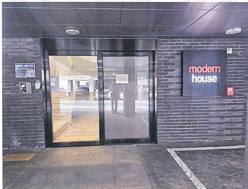
본건물내 공동출입구 전경
