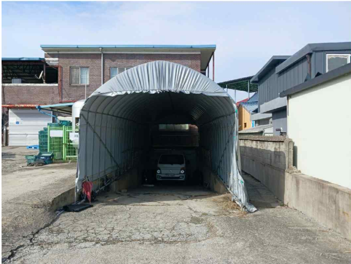
기호(4) 건물 지하실 입구 및 제시외 비닐 차양 근경
