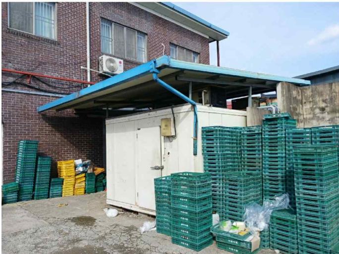
제시외 건물 ㉖ 및 냉장창고 근경
