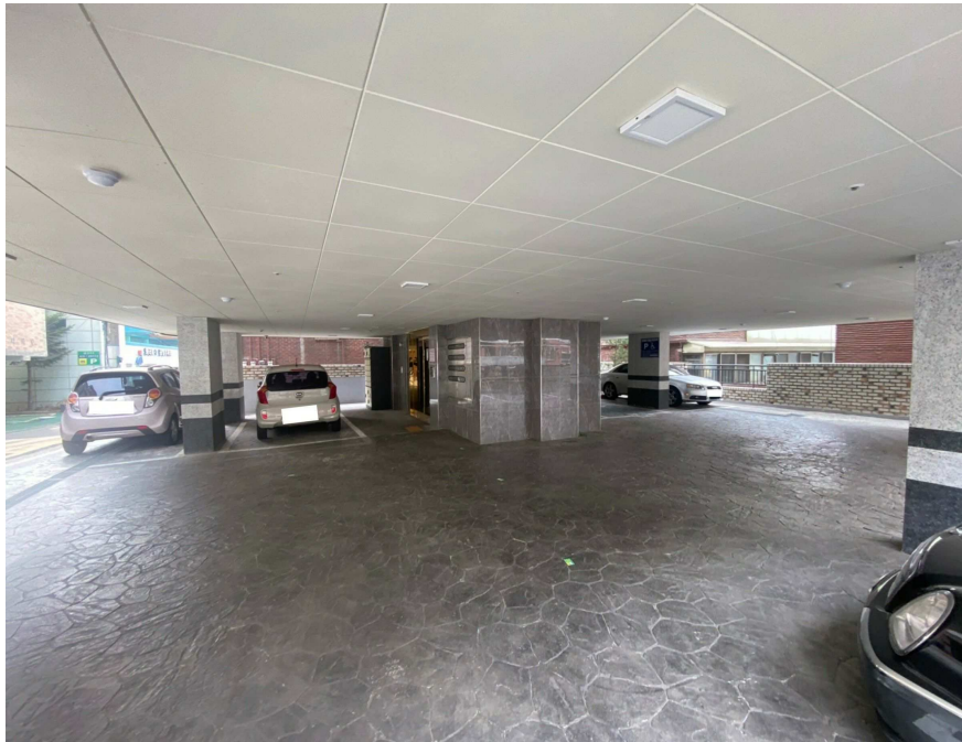
본건 건물 1층 전경
