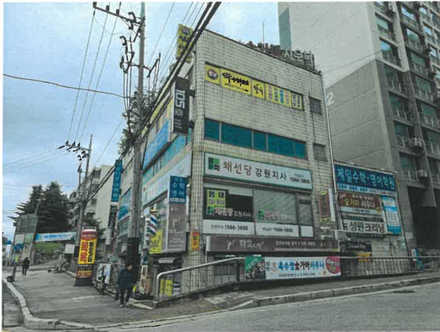
본건 외부 전경
