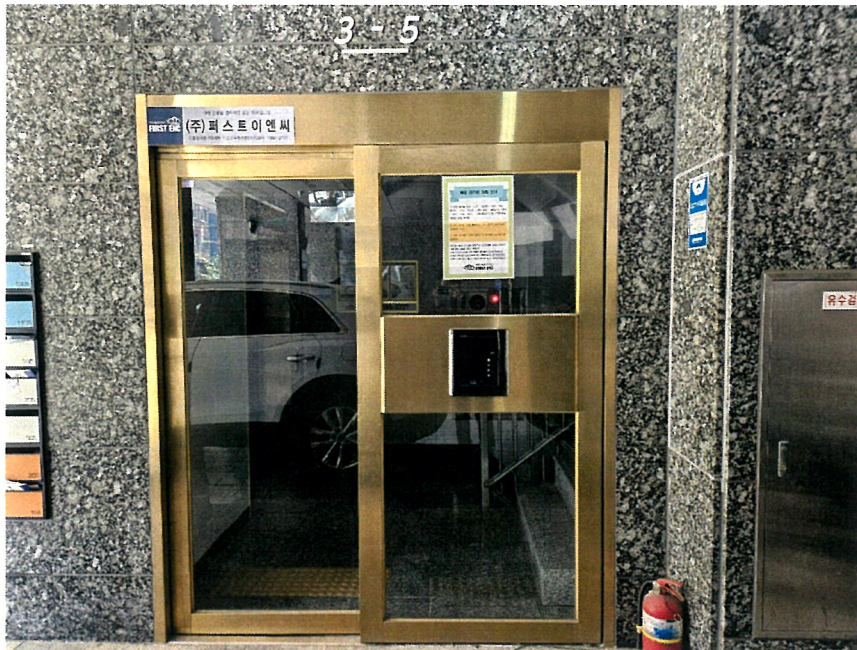
본건이 속한 건물 공동 출입문
