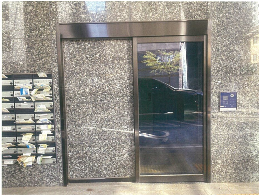
본건 소재 건물 공동출입구
