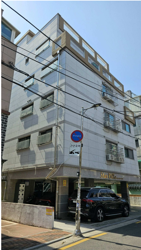
< 남동측에서 본 본건 소재 건물 전경 >
