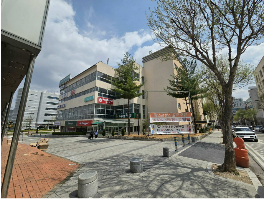
본건 외부 전경
