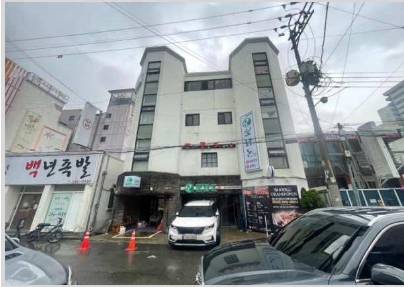
본건 기호 1),2) 및 제시외 건물 ㄱ),ㄴ) 전경
