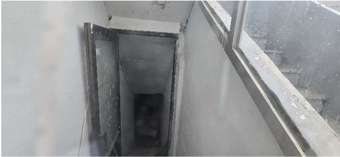
【본건전경 [일련번호 2] 지하】
